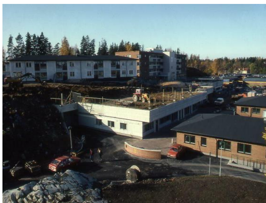
Grannskapscentralen (under byggnation)
